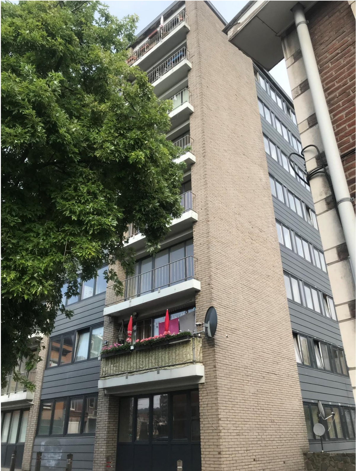
Figure 9. Vue de la façade sud-ouest
