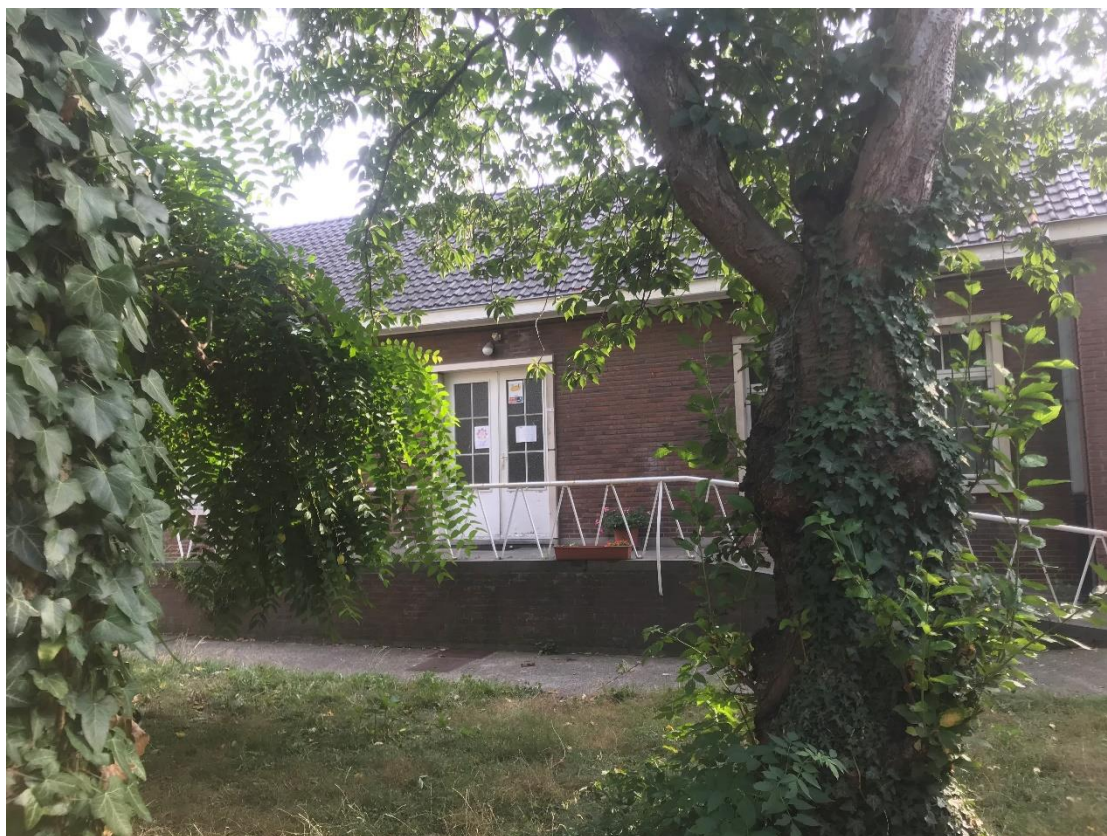
Figure 8. Vue du bâtiment du CPAS
