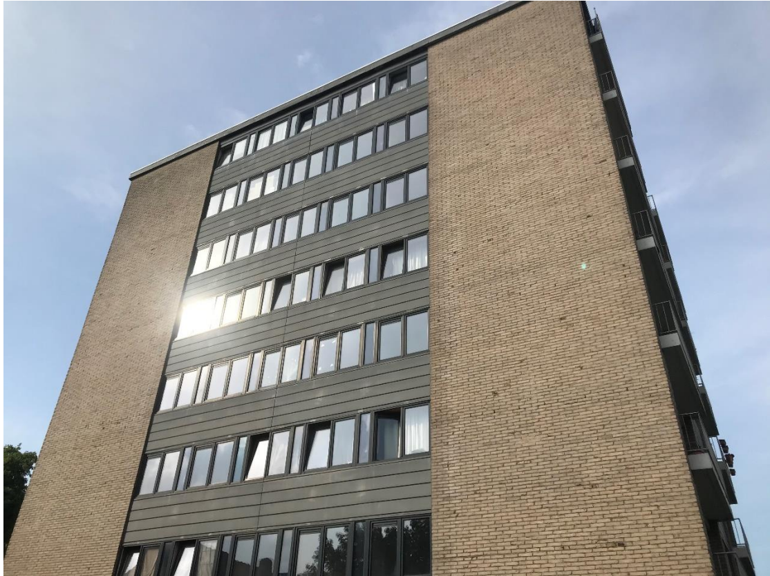
Figure 5. Vue de la façade sud
