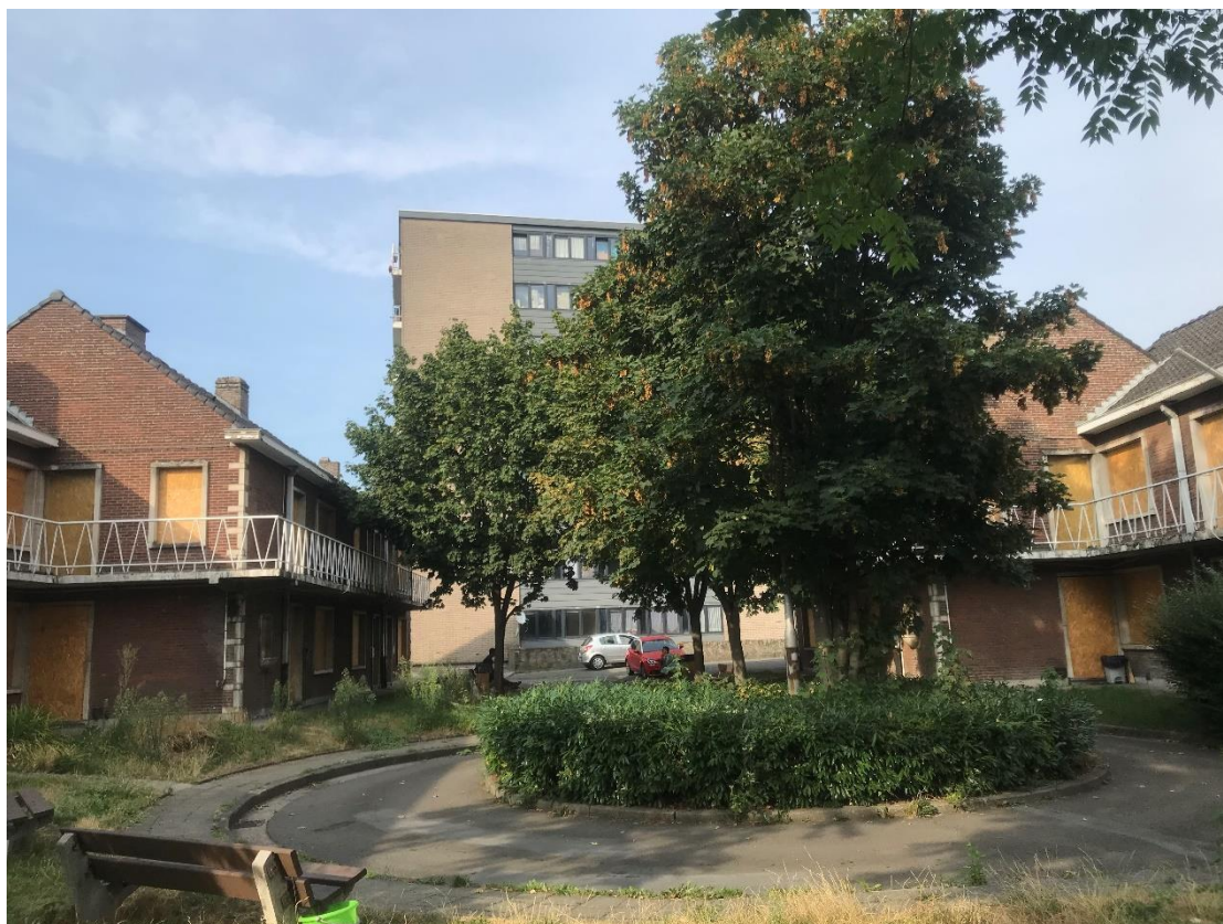
Figure 7. Vue de la placette / rond-point central
