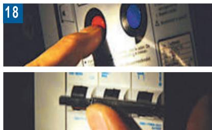
18 Dans ce cas, appuyez une nouvelle fois sur le bouton rouge et réarmez si nécessaire le disjoncteur.
