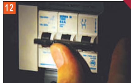
12 réarmez si nécessaire le disjoncteur, vous disposerez d'un crédit de secours limité, sans limitation de puissance.
